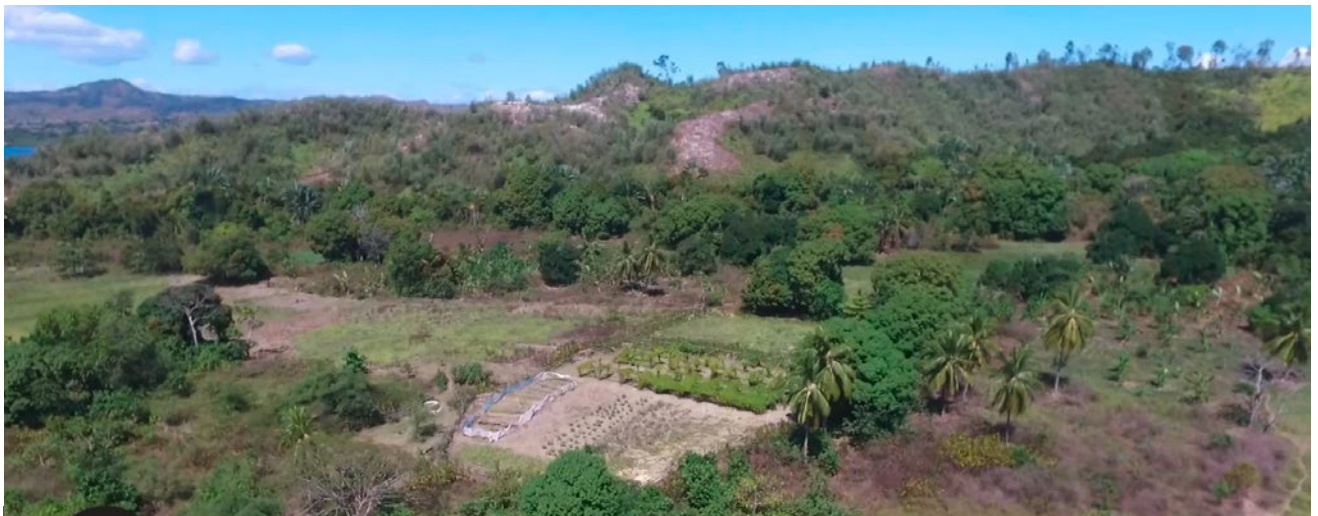
Auffangbecken der Laugungslösung auf entwaldeten Flächen auf Ampasindava, © CRAAD-O
